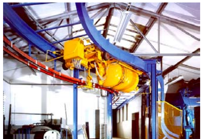
Voeding en besturing van een betonkubel
