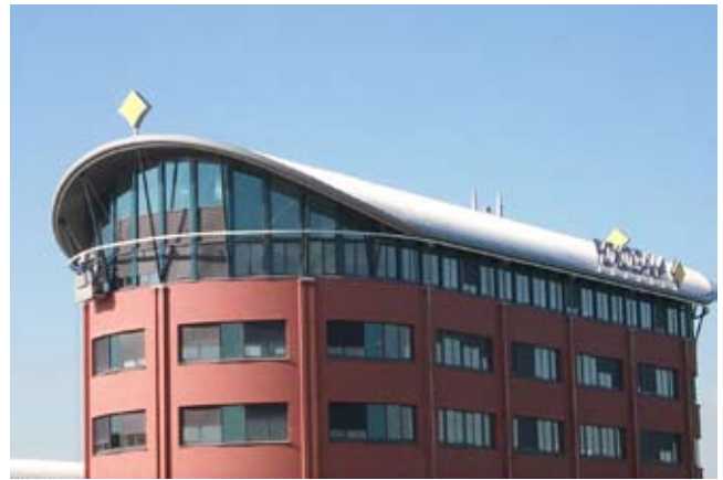
Installatie met bochten ten behoeve van gevelreiniging
