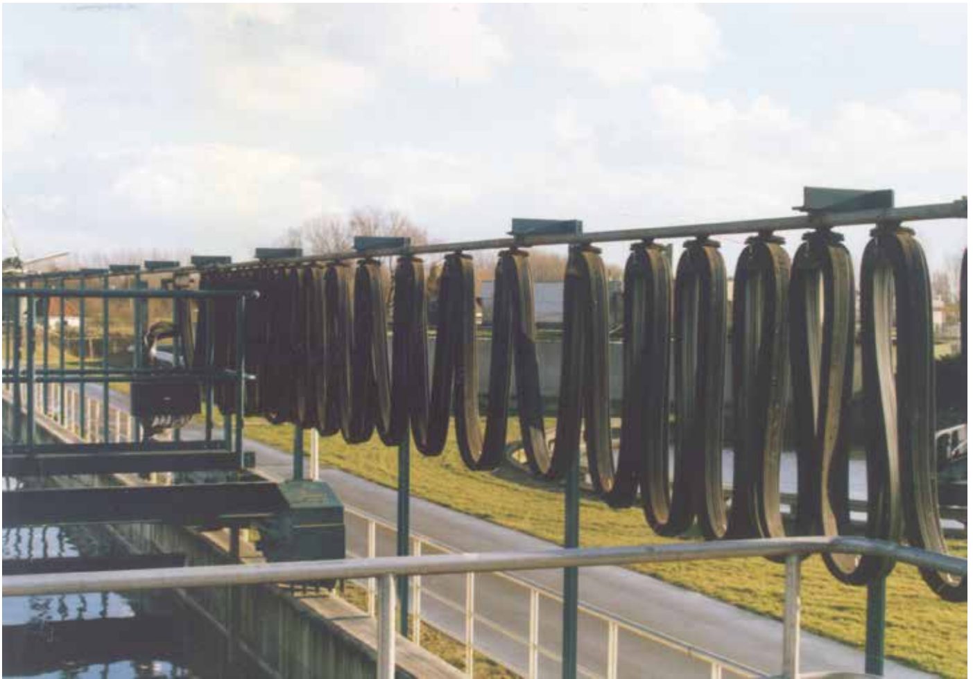
AKAPP Festoen-installatie met vlakke kabels bij een rioolwaterzuivering
